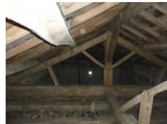
Figure 48 : Partie est des combles (Photo : Michaël Gamarde)
