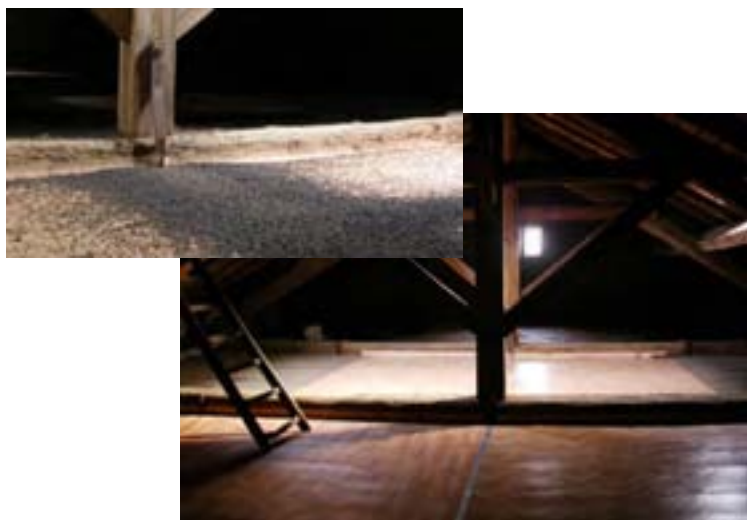
Figure 40 : Combles de l'école de Fontenoy-le-Château après installation du linoleum (Photo : Christophe Borel)
