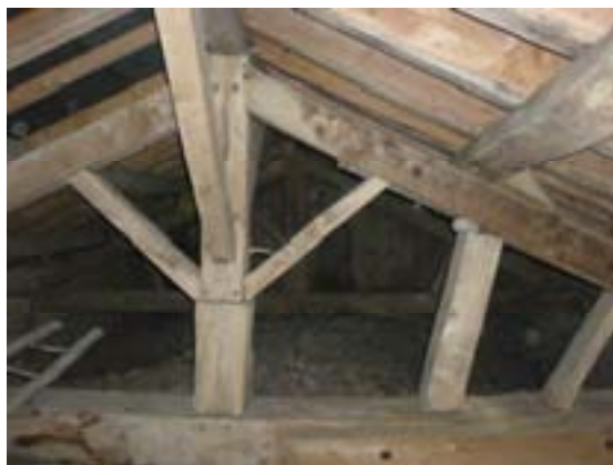
Figure 46 : Partie ouest des combles (Photo : Michaël Gamarde)
