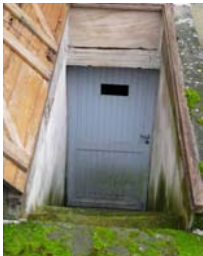
Figure 22 : Porte d'accès à la cave avec ouverture à chiroptères (Photo : Michaël Gamarde)
