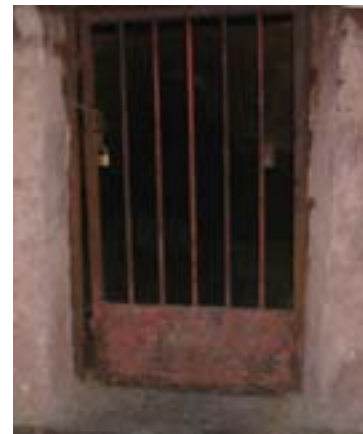
Figure 36 : Grille actuelle entre le porche et la galerie (Photo : Michaël Gamarde)
