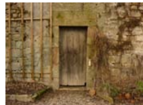
Figure 28 : Entrée de la cave du parc du château de Châtillon-sur-Saône (Photo : Michaël Gamarde)
