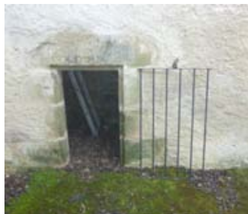
Figure 45 : Accès aux combles (Photo : Michaël Gamarde)
