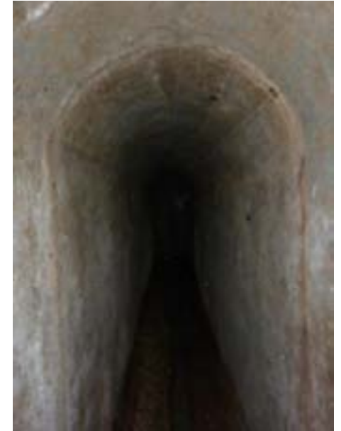
Figure 17 : Galerie de captage (Photo : Michaël Gamarde)
