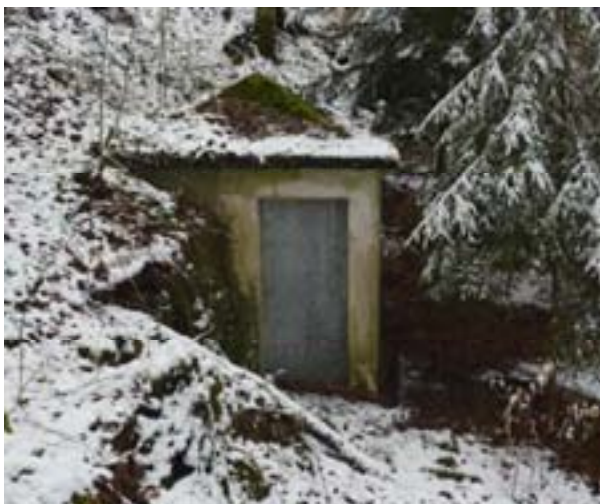
Figure 15 : Entrée du captage d'eau (Photo : Michaël Gamarde)
