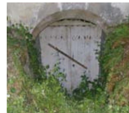
Figure 24 : Porte d'accès à la cave sans accès à chiroptères (Photo : Bruno Discours)
