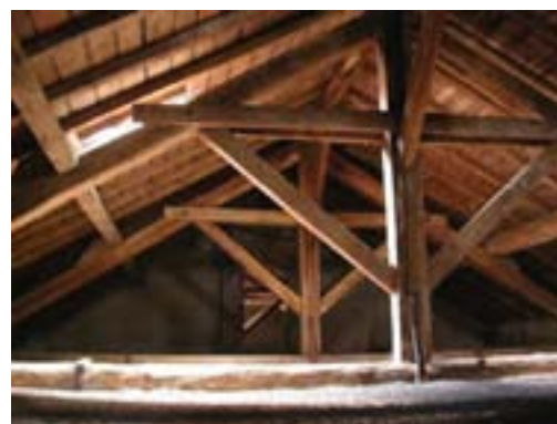
Figure 39 : Vue des combles de l'école de Fontenoy-le-Château (Photo : Christophe Borel)
