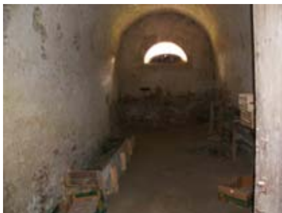
Figure 50 : Pièce de la cave de la mairie de Monthureux-sur-Saône avec ouverture en demi-lune (Photo : Michaël Gamarde)
