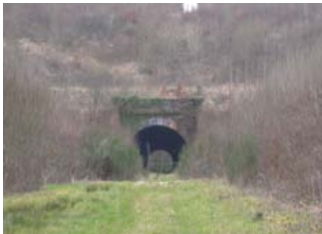
Figure 56 : Entrée nord du tunnel désaffecté de Regnévelle/Martinville (Photo : Christophe Borel)
