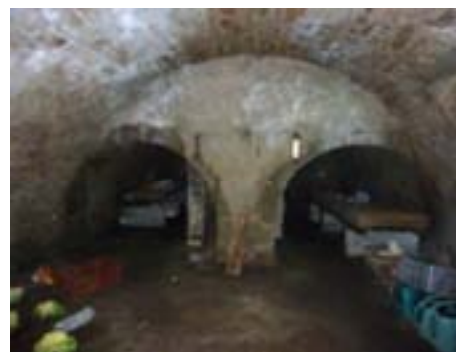
Figure 29 : Cave du parc du château de Châtillon-sur-Saône (Photo : Michaël Gamarde)
