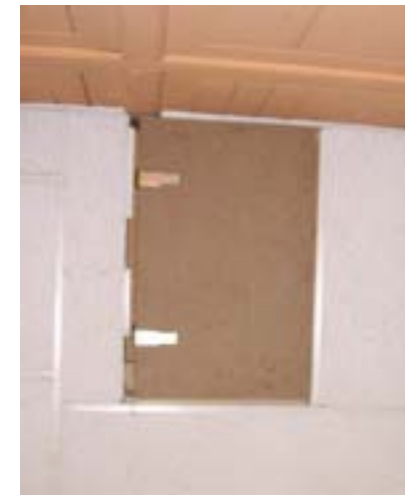
Figure 41 : Trappe d'accès aux combles de l'école de Fontenoy-le-Château (Photo : Christophe Borel)
