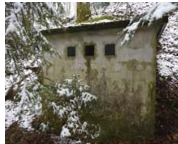
Figure 16 : Ouverture accessible par les chauves-souris (Photo : Michaël Gamarde)
